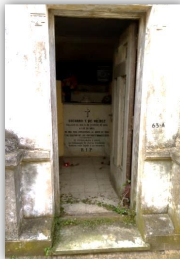
Imagen nº 42: entrada de la bóveda
