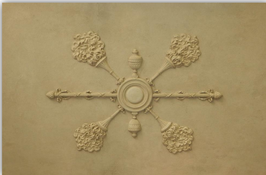
Imagen n° 3: detalle cielorraso en las galerías de nichos laterales de la entrada (paralelas a calle Almafuerde)
