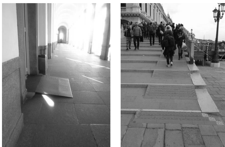
6.5.3. Museo Reina Sofía de Madrid, rampa salva-escalón. Puente de San Marcos en Venecia, solados podotáctiles en pequeñas rampas exteriores para salvar escalones. Imágenes archivo personal.
