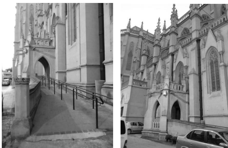
6.5.2. Catedral de los Santos Pedro y Cecilia en Mar del Plata, incorporación de rampa de acceso exterior. Proyecto Arq. Máximo Bonetti y Restauradora Rosario Jorge, 1991-2005. Imágenes de archivo personal.
