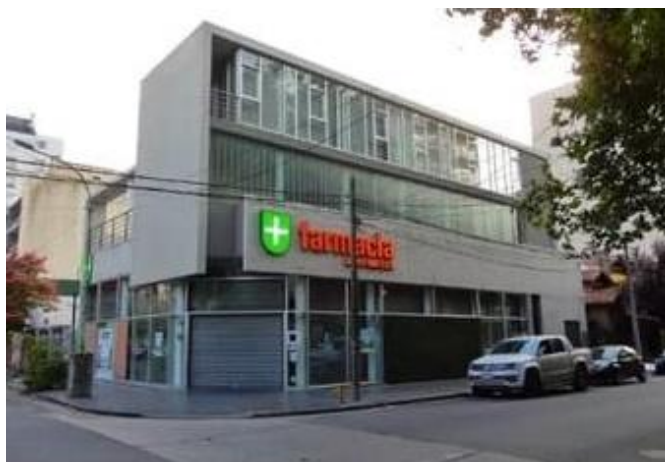
Los dos chalets anteriores fueron demolidos para construir la franquicia Farmacity.
