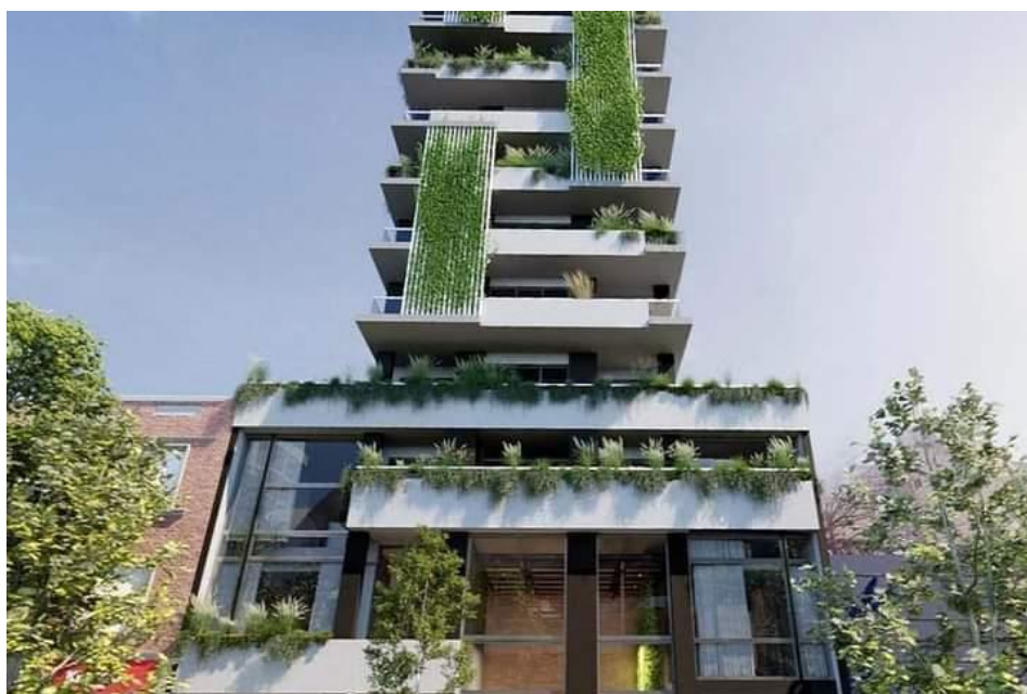
Proyecto en obra sobre terreno del ex cine San Martín.
