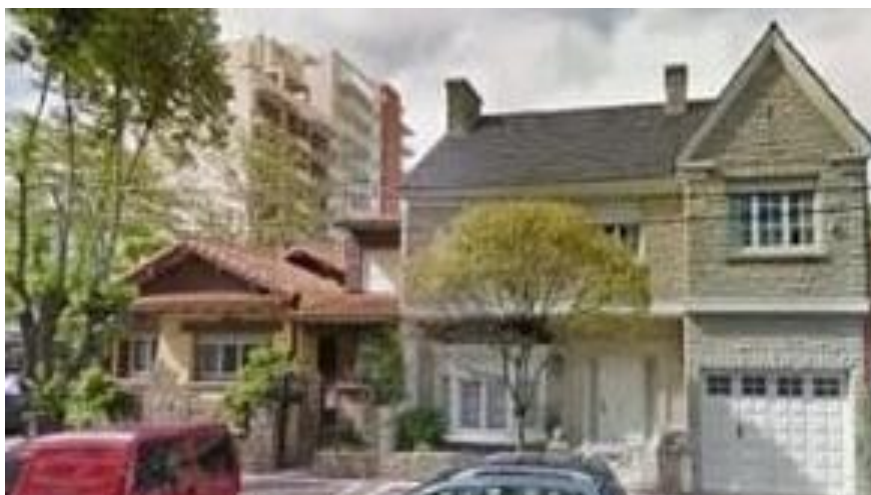
Chalet en Gascón entre Yrigoyen y Mitre (demolido).
