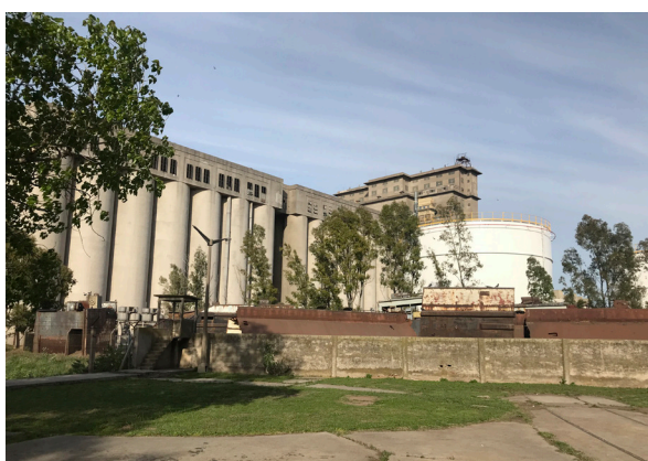
Figura 21 Elevador III y pasaje con restos de barcos abandonados
