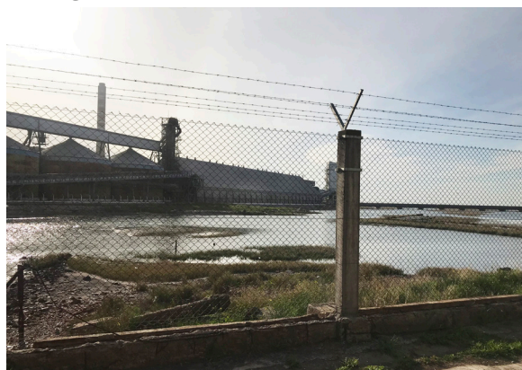
Figura 24 Desde la Rambla Arrieta, vista de la Terminal Toepfer, ADM Agro
