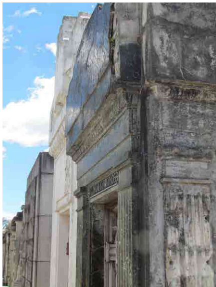
Foto 1 y 2 Rotura de material pétreo de revestimiento – Los colores oscuros atraen el calor con mayor intensidad.
