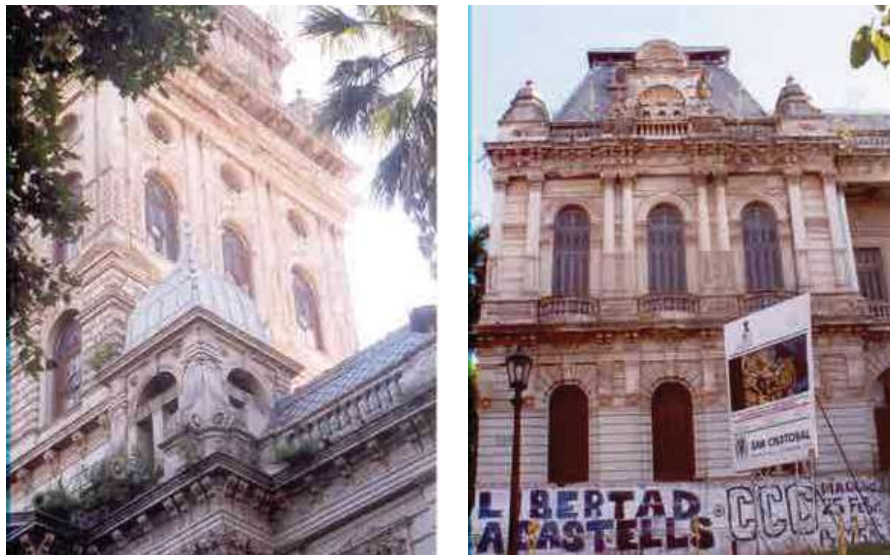
Vistas de diferentes sectores de fachadas que muestran el estado previo a las decisiones de intervención. Pintura, desprendimiento, crecimiento de especies vegetales, entre otros. Fuente F.P.B.
