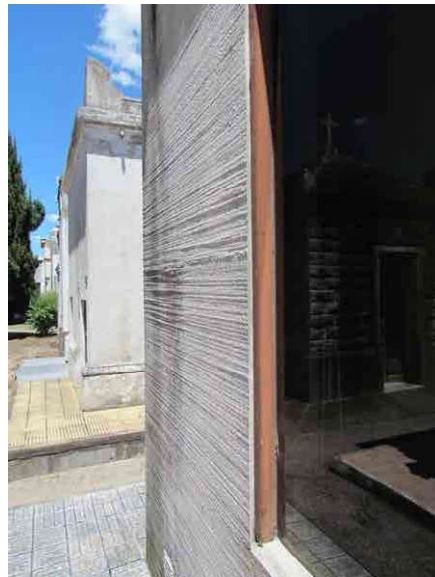
Foto 4 – terminación exterior de bóveda
