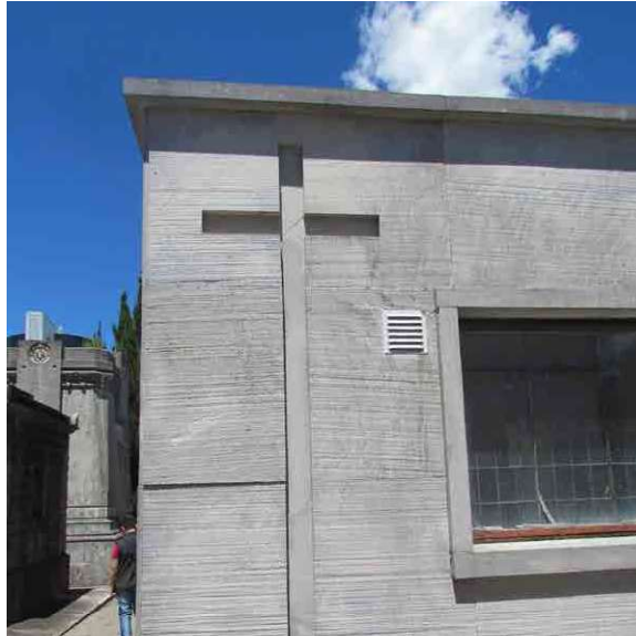
Foto 5 – Trabajos sobre superficie en roca
