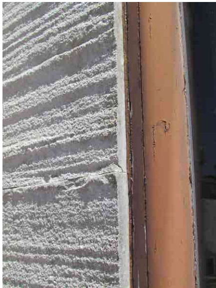
Foto 3 – Placas de revestimiento travertino
