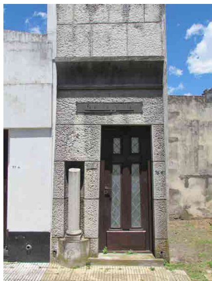
Foto 1. Presencia de suciedad por absorción
