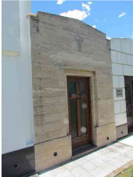
Foto 1 – Revestimiento de mármol travertino
