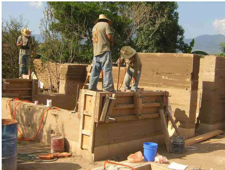
En Oaxaca, México, se usan adobes y tapias para la nueva edificación. Fuente: Red PROTERRA. 2011
