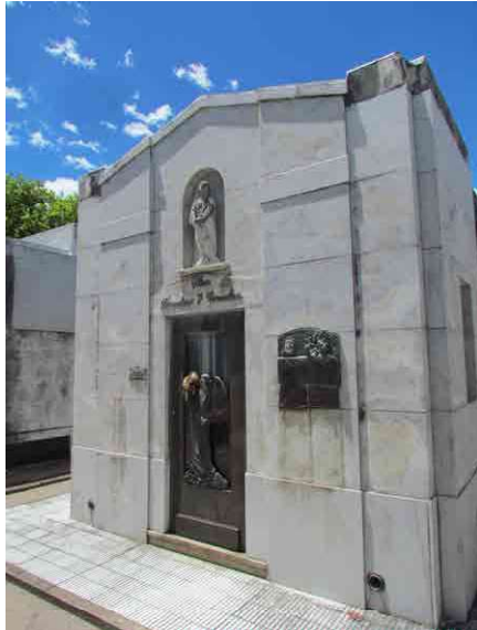
Foto 1 - Bóveda revestida en placas de Mármol
