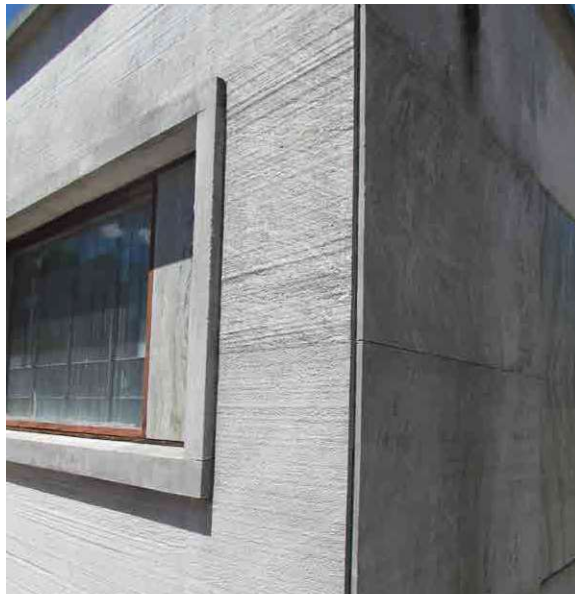
Foto 6 – Trabajos exteriores en travertino
