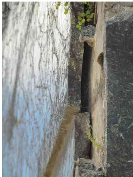
Foto 1 y 2 Rotura de material pétreo de revestimiento – Los colores oscuros atraen el calor con mayor intensidad.
